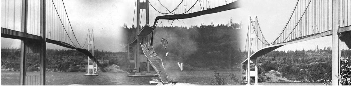
Şekil 1. Tacoma Asma Köprüsü'nün rezonans etkisiyle yıkılması [2]
