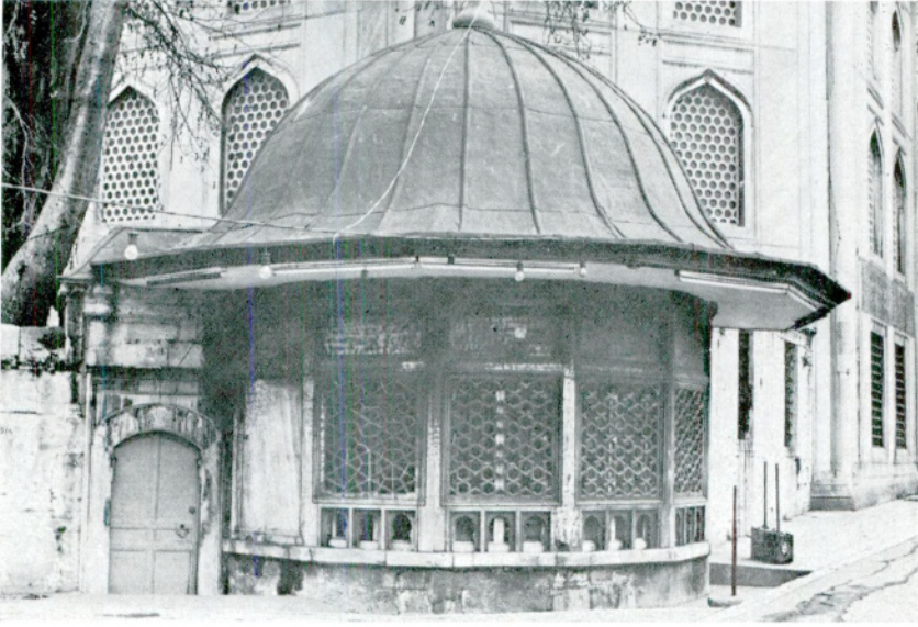
Res. 19 — Ayasofya camii dış duvarı köşesindeki Sultan İbrahim sebili
