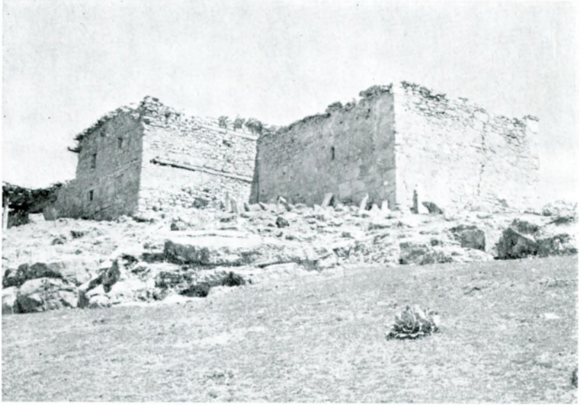
Res. 3 — Güney batı görünüşü
