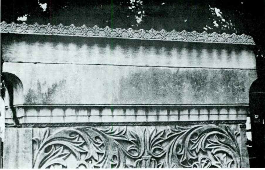
Res. 7 — Çeşmenin arka cephesi üst bölümü
