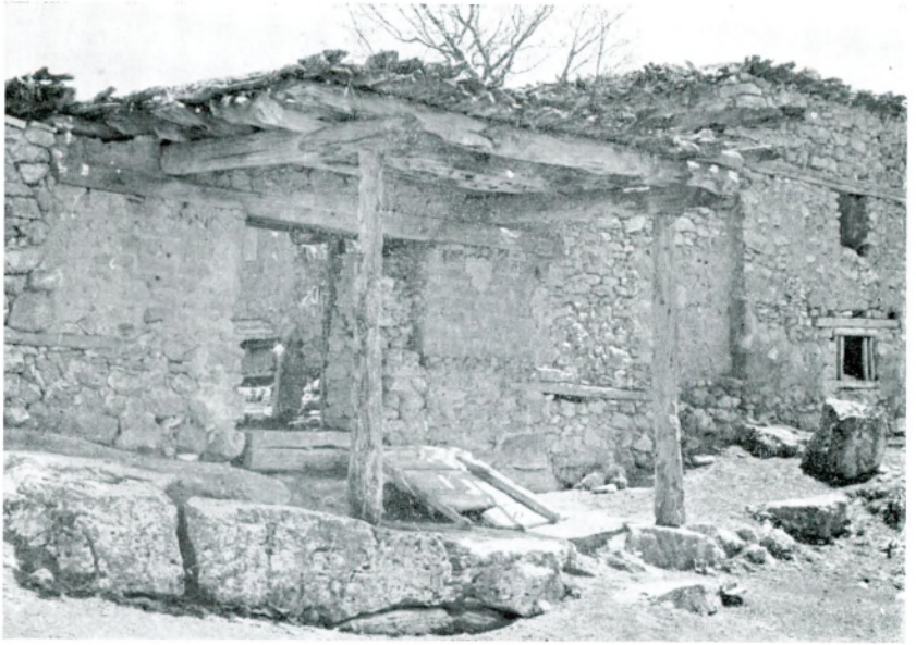
Res. 4 — Batı cephe, avluya giriş kapısı
