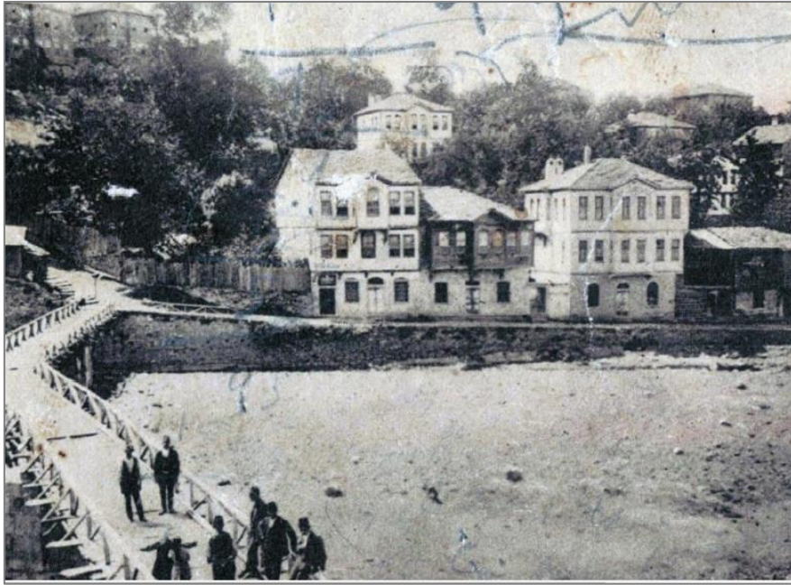
Resim 7. Kâgir ayaklı ahşap tablalı köprü-1950.
