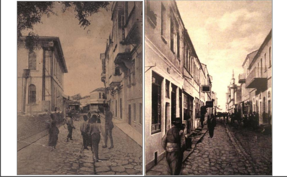
Resim 13., 14. Günümüzde Kâşif Bey Caddesi olarak adlandırılan İskele Caddesi (N. Sakağlı Arşivi) ve Galip Deniz Caddesi'nin 20. yüzyılın başındaki görüntüsü (M. Fakazlı Arşivi)
