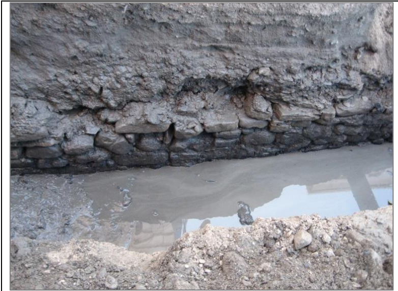
Resim 10. İnebolu Belediyesi'nin altyapı çalışmaları sırasında açığa çıkan eski kanal sistemi (M. Fakazlı Arşivi)
