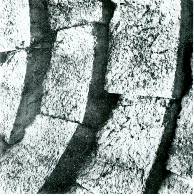
Res. 14 — Kubbenin üst taşdizilerinin vücade getirdikleri kademeler (dişler)
