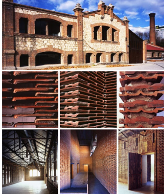
Şekil 7. Mezbaha binası ve eski kiremitlerden oluşan nefes alabilen yeni duvarlar
