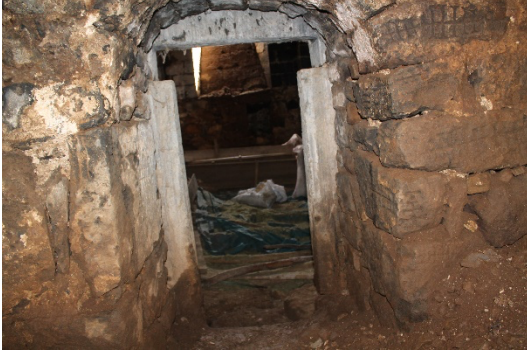
Şekil 29: Kapı iç mekandan görünümü
