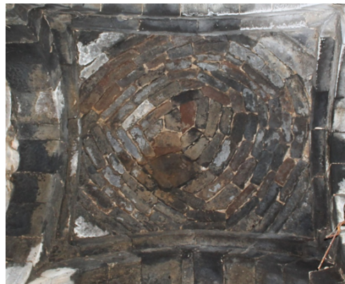
Şekil 20: Basık kubbe örtü sistemi
