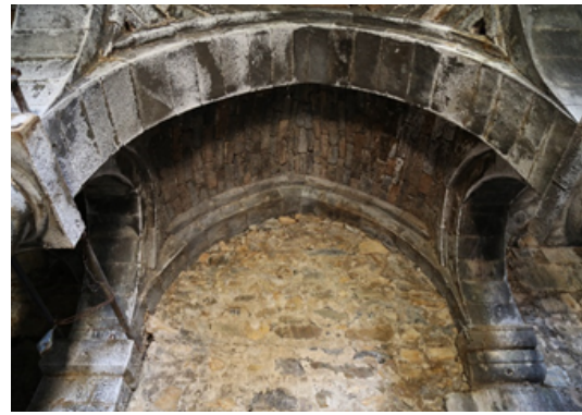
Şekil 11: Yan nef tonoz örtü sistemi
