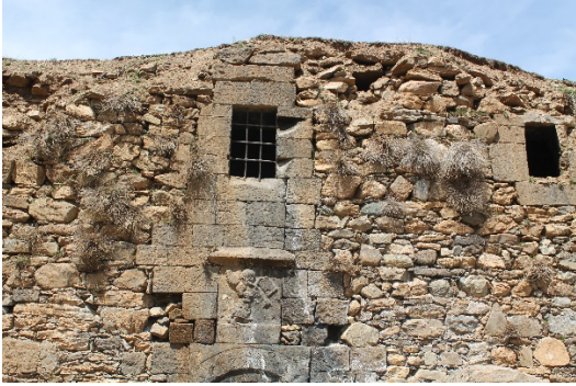
Şekil 21: Güney dış çephe pencereleri
