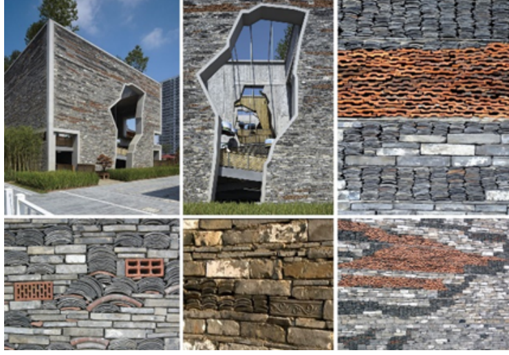
Şekil 5. Duvarlara tuğla ve kiremitlerin Wa Pan tekniğine göre yerleştirilmesi
