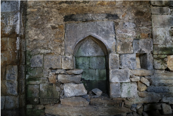
Şekil 23: Güney dış çephe pencereleri
