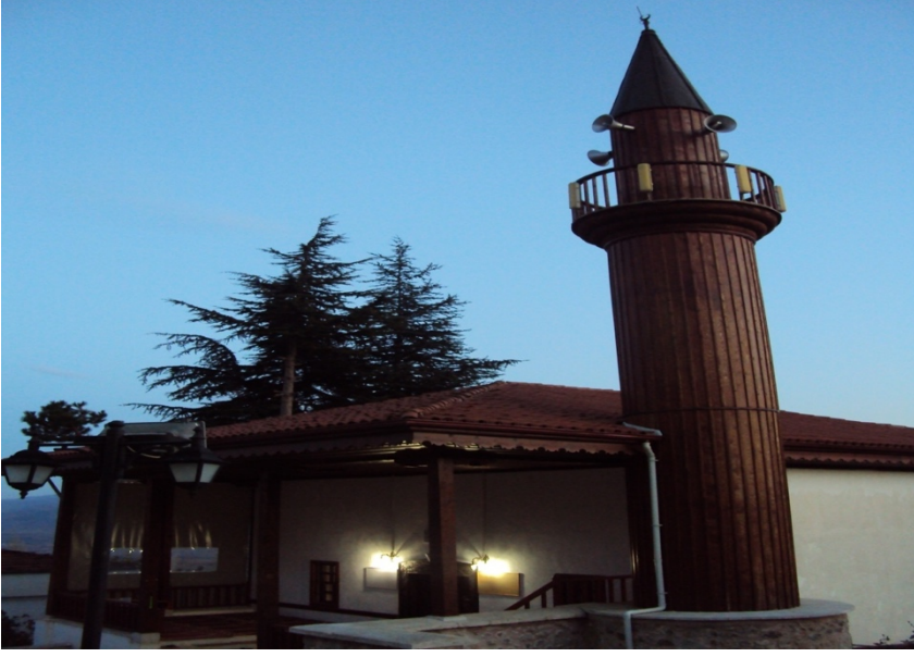
Resim 1: Aşağı Baraklı Camii genel görünüşü. (Yazarın kişisel arşivindedir.)
