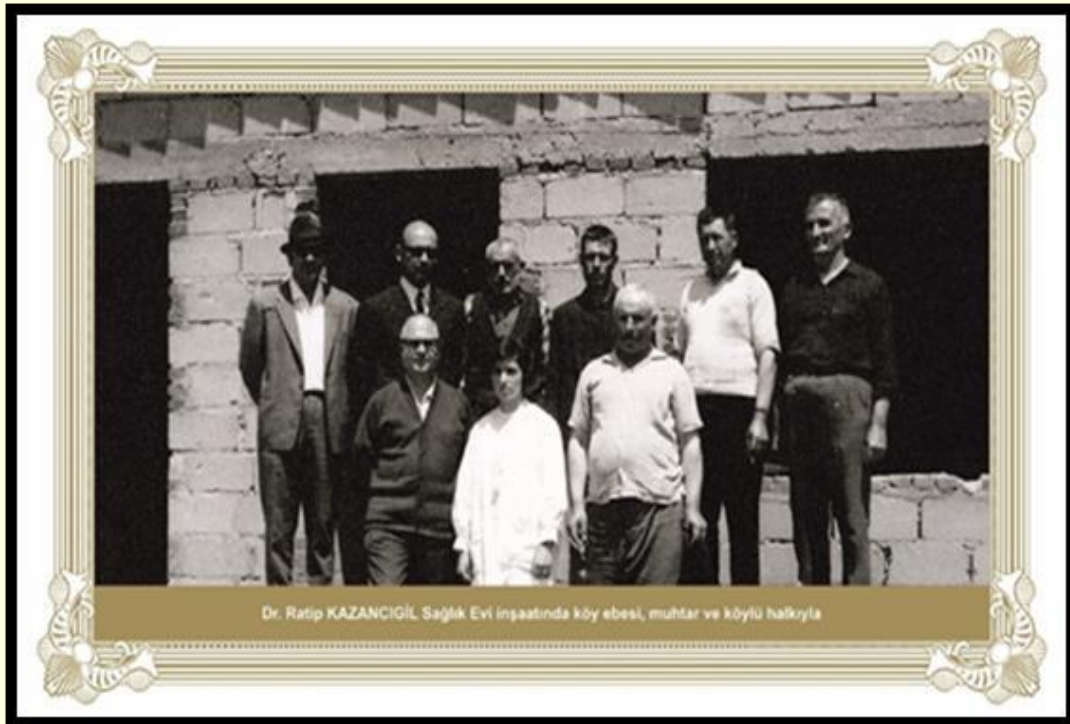
Şekil 11. Köy Sağlık Evi inşaatında sağlık ekibi ile beraber
