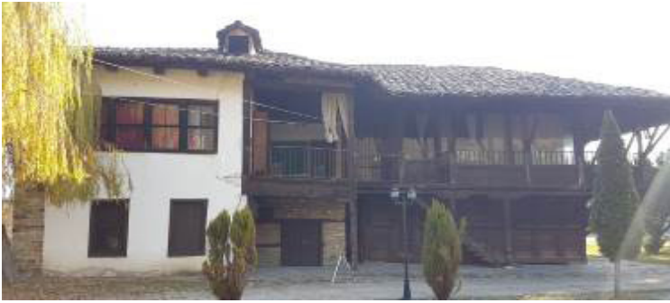
Şekil 28: Yığma Taş ve Ahşap Karkas Yapım Sistemlerinin Birlikte Kullanıldığı Misafirhane Giriş Cephesi. (Fotoğraf: Ekol Mimarlık Arşivi)
