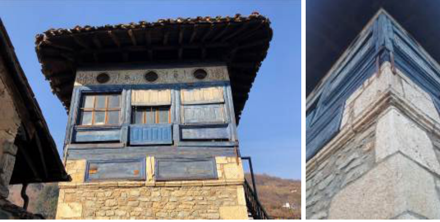
Şekil 20: Fatma Evinin Kargir Zemin Katına Ait Kesme Taş Bloklar İle Çatı Bitirme Elemanları. (Fotoğraflar: Ekol Mimarlık ve Deniz Özkut Arşivleri)
