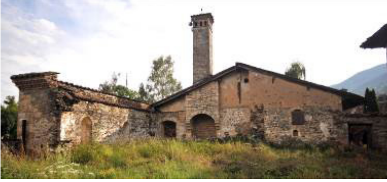
Şekil 13: İbadethane Yapısı Hazırlık Mekânı. (Fotoğraf: Ekol Mimarlık Arşivi)
