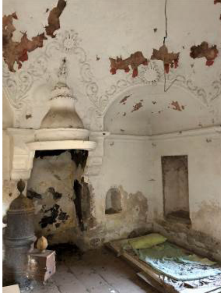
Şekil 17: Fatma Evi Zemin Kat Mekânında Bulunan Ocak ve Metal Profilli Alçı Süslemeli Kubbe. (Fotoğraf: Ekol Mimarlık Arşivi)
