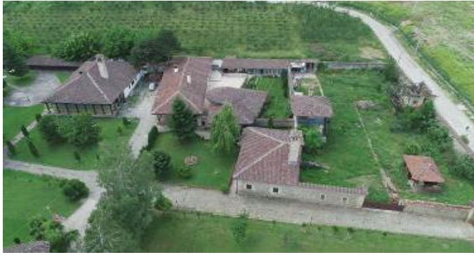
Şekil 11: Önde İbadethane Yapısı Meydan Evi ve Yıkılmış Hazırlık Mekanı. (Hava Fotoğrafı: Ekol Mimarlık Arşivi, 2018)
