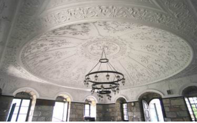
Şekil 12: Meydan Evinin Alçı Kabartmalı Sıvalı Basık Kubbesi. (Fotoğraf: Ekol Mimarlık Arşivi)
