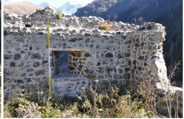
Res. 48. Güney Sur Duvarındaki Pencere
