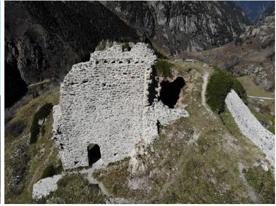
Res. 57. Kuzey Cephesi İç Tarafı
