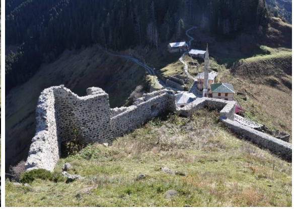
Res. 46. Kale-i Bala Güney Sur Duvarı
