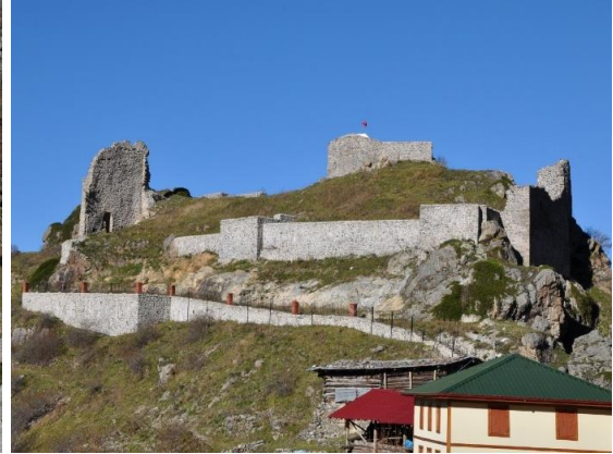
Res. 50. Batı Sur Duvarı
