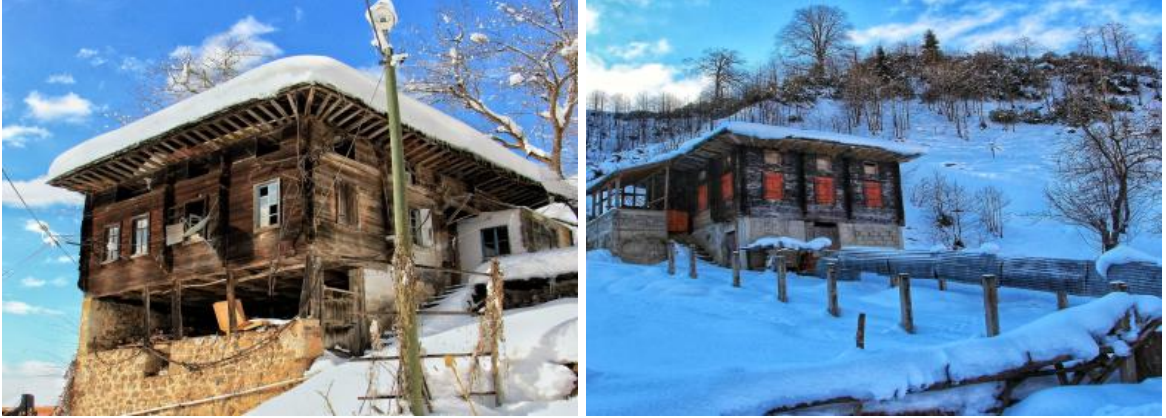
Res. 3, 4. Taş Duvar Kurgusu, Ahşap Çatki Sistem Bağlantılı Geleneksel Evler (N. Yazıcı Arşivi)
