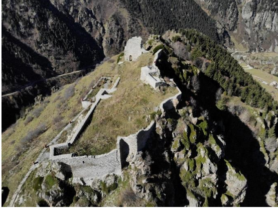
Res. 45. Kale-i Bala Güney Cephe
