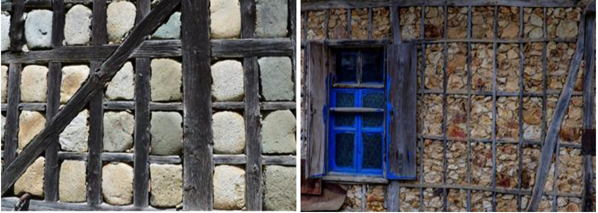
Res. 5, 6. Geleneksel Evlerin Dolgu Tekniklerinin Farklı Malzemeyle Uygulamaları (F. Şahin Arşivi)
