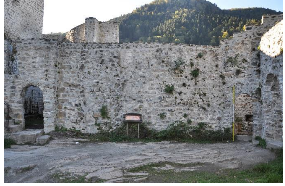
Res. 18. Mekanlara Giriş Kapıları
