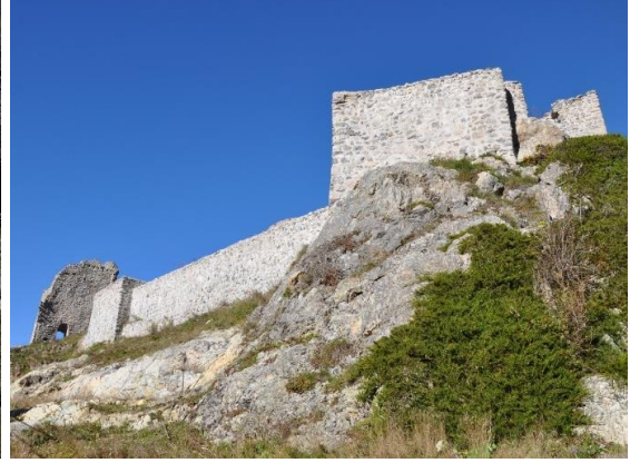
Res. 52. Batı Sur Duvarı ve Burçları
