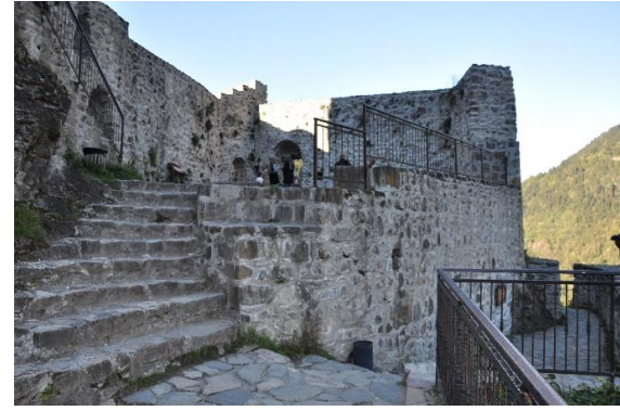
Res. 14. Koridor ve Avluya Geçiş
