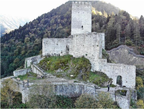
Res. 7. Zir Kale Kuzeydoğu Cephe
