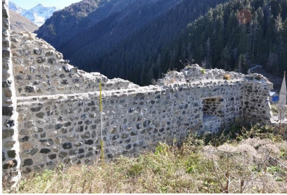
Res. 47. Güney Sur Duvarı
