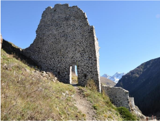
Res. 56. Kuzey Cephesi Dış Tarafı
