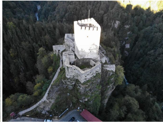
Res. 8. Zir Kale Güneybatı Cephe
