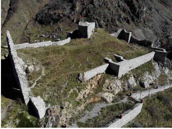
Res. 51. Kuzeybatı Cephe
