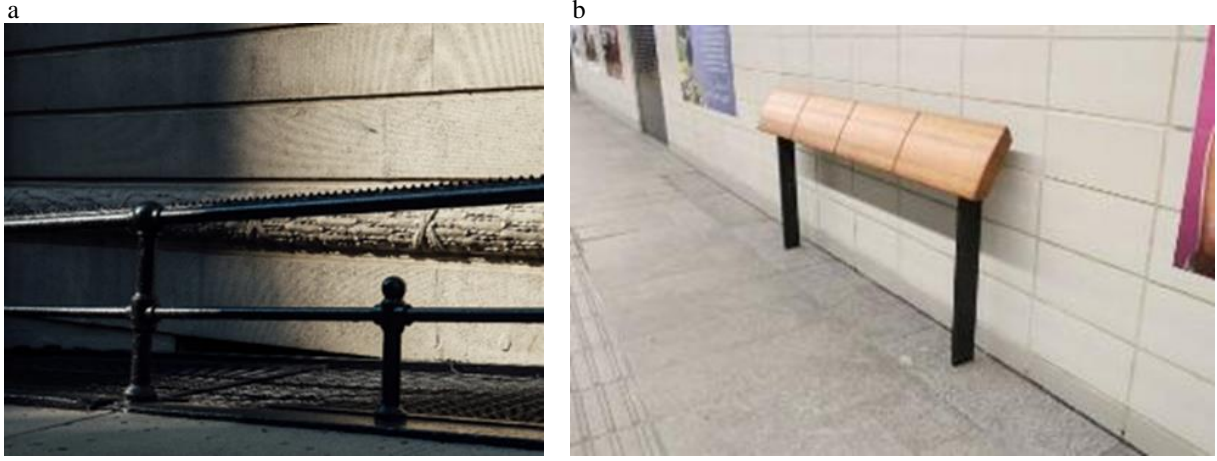
Şekil 5. (a) New York'ta tutunmayı engelleyen korkuluklar (New York Times, 2019) (b) New York'ta metrosunda oturma'nın engellenmesi (Ruetas, 2022)
