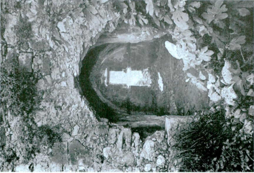
Resim 21 — Kuzey Batı Cephesindeki Ana Giriş Kapısı
