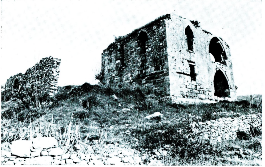
Resim 5 — Güneydoğu - Güneybatı Görünüşü ve Yan Bahçe Duvarı
