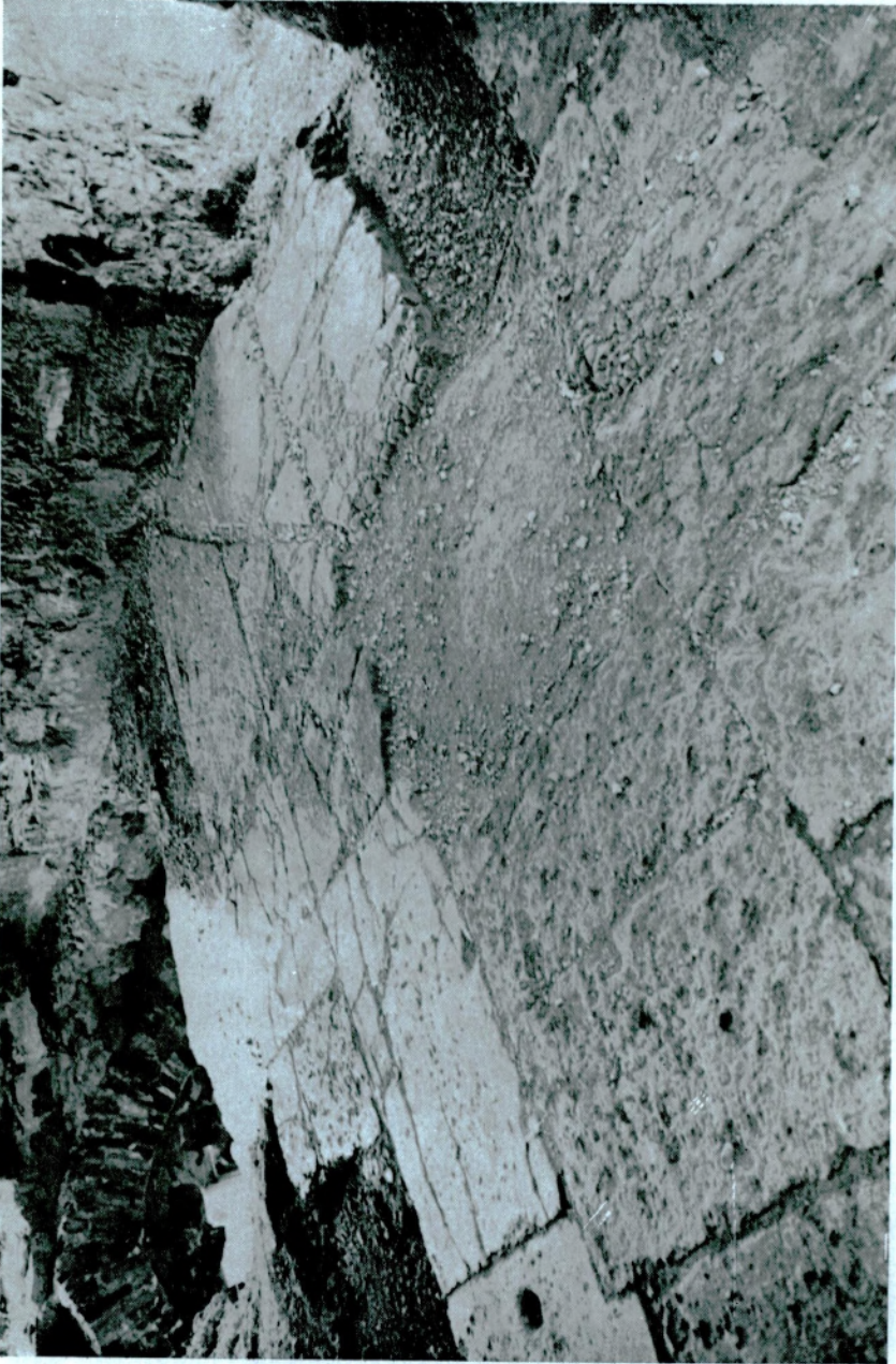
Resim 16 — Birinci Kat Salonunun Taban Döşemesi ve Havuzu
