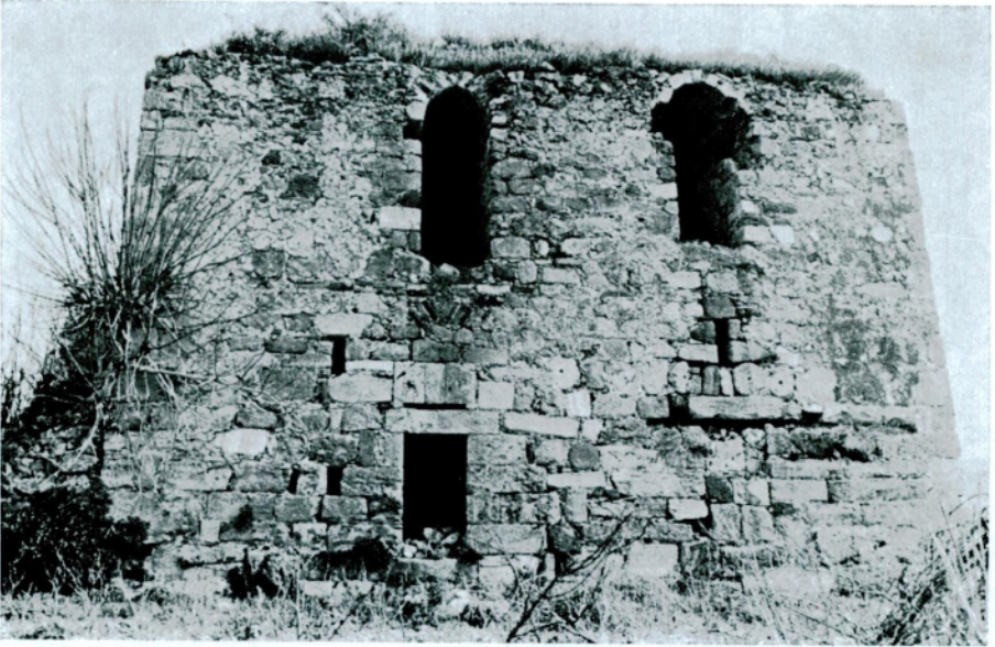
Resim 2 — Güney - Batı Görünüşü
