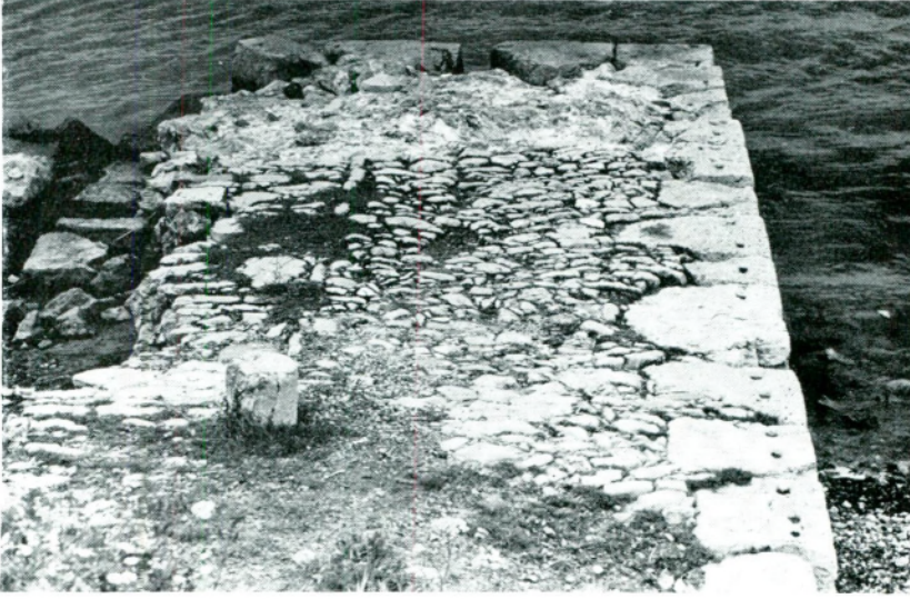
Res. 25 — Dil'deki taş iskelenin kaldırımı üst sathı.
