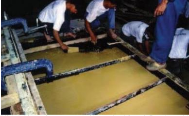
Şekil 3.1. Yüzey karışımının kalıba yerleştirilmesi (Demirtaş, 2010)
