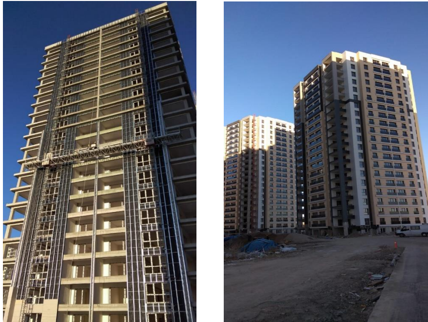
Şekil 4.2. Mevaşehir Eryaman, montaj işlemi devam ederken cephe görünüşü, montaj işlemi tamamlandıktan sonra cephe görünüşü
