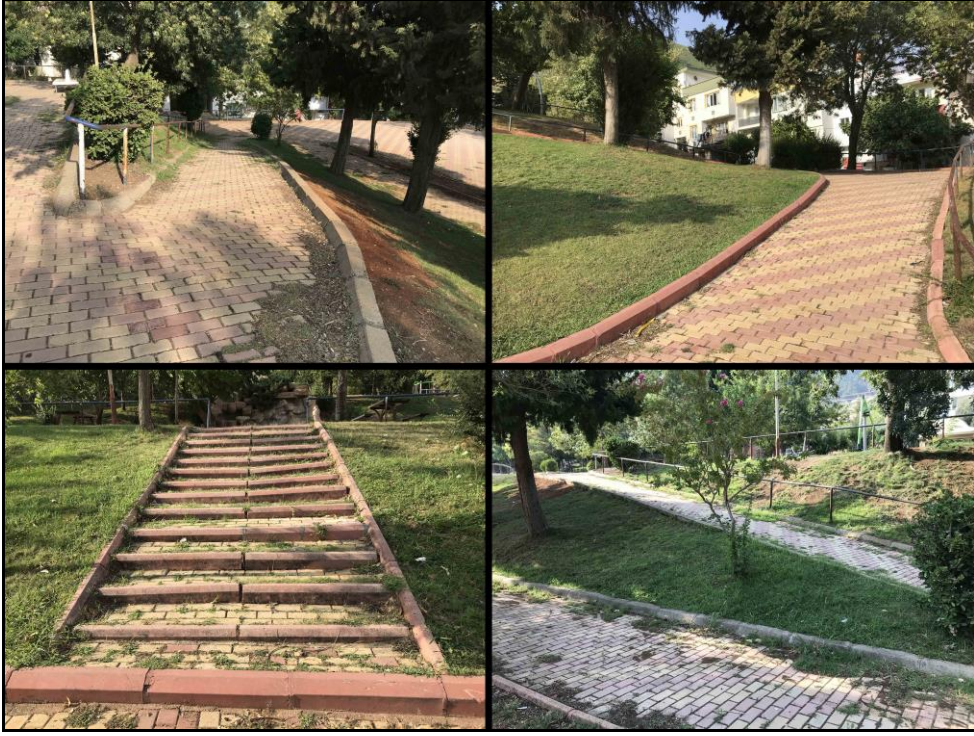
Şekil 3. Rampalar ve Merdivenler
