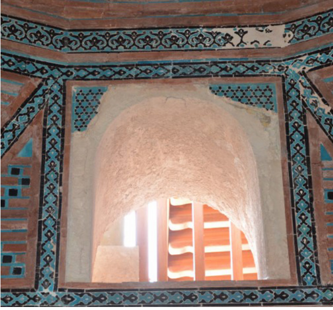
Resim 5. Mescit, Türk Üçgeni (Doğu) Niş Köşelik Çinileri, Birim Malzeme Kaybı (Konak)
