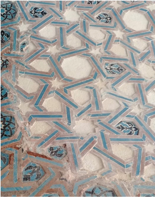
Resim 17. Medrese, Kuzey Eyvan Tonoz Örtü, Tamamlama (Konak)
