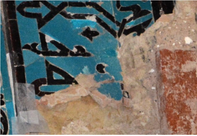
Resim 11. Mescit, Mihrap Kuşak, Sol Taraf, Parça Kaybı (Onarımlardan Önce) (Konak)
