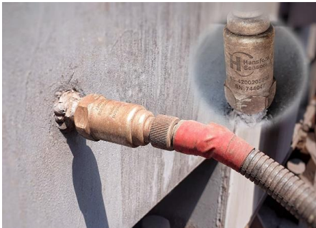
Şekil 2. Motor gövdesindeki Hansford marka vibrasyon sensörü
