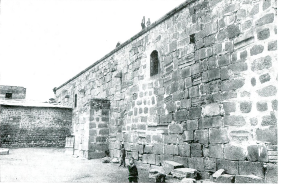
Resim 4 — Hacı Kılıç camisi mihrap duvarı.
