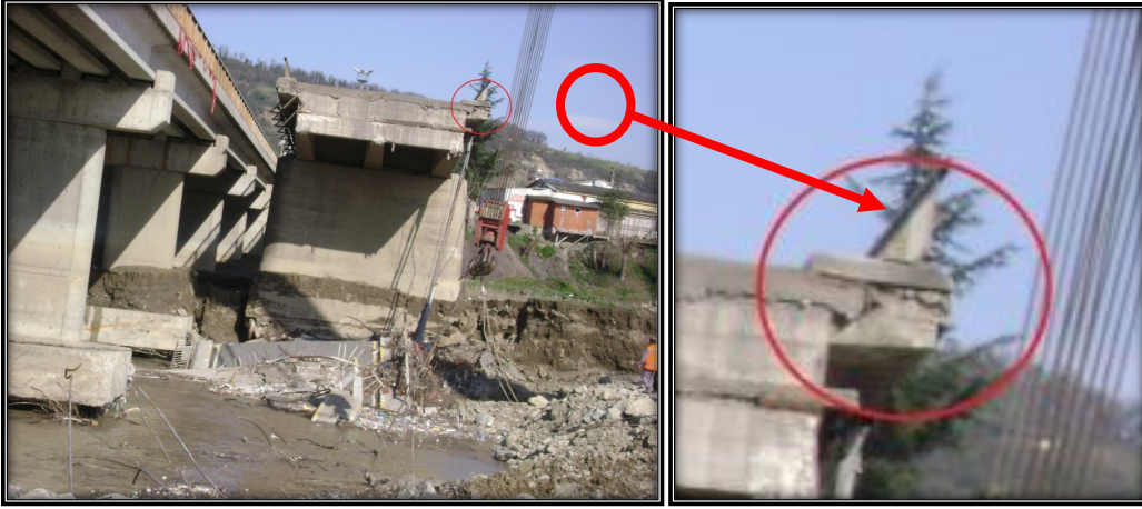
Şekil 8. Vaka çalışması köprüsünün ve genişletilmiş kaldırımın çöküşü (KGM, 2012)
