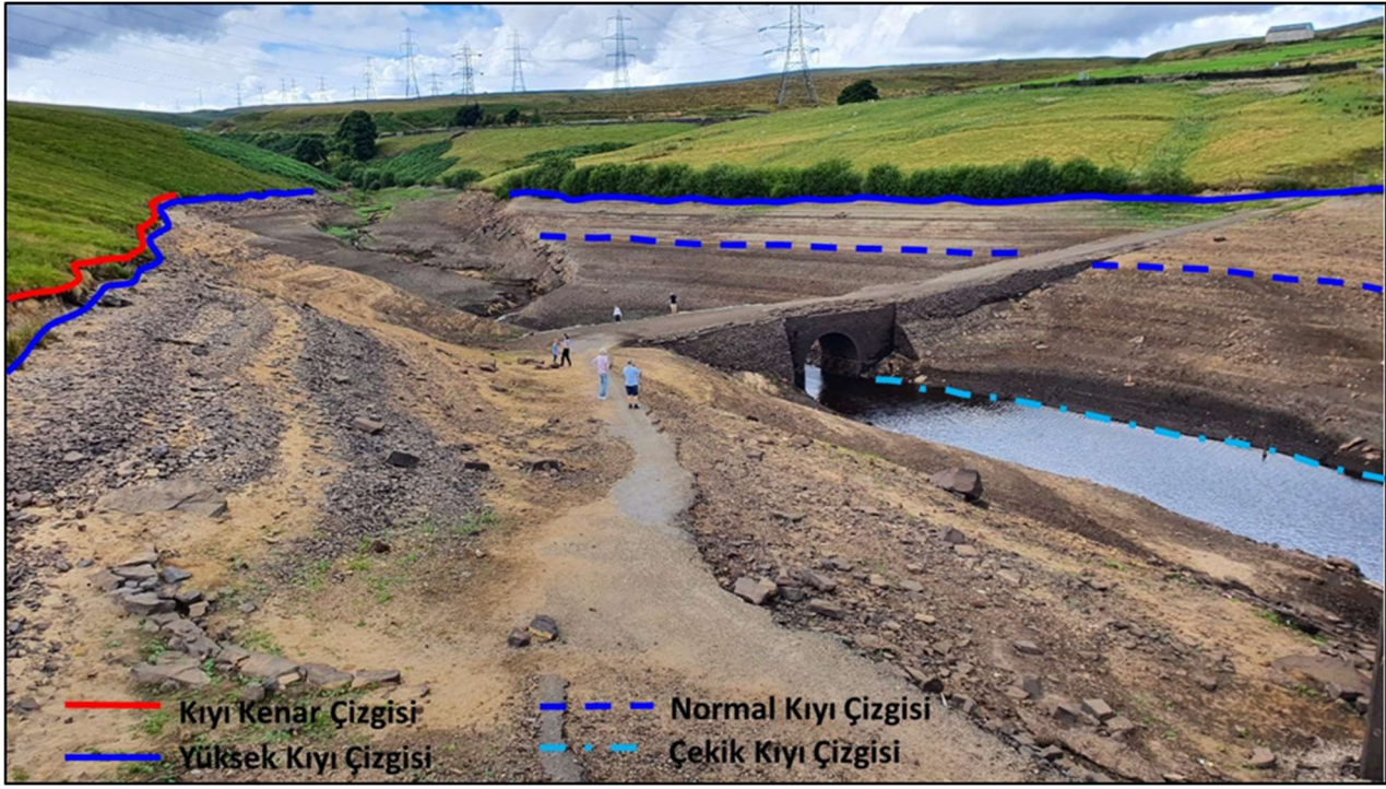
Şekil 7: Akarsu su seviyesi yüksekliği ve kıyı çizgileri. Farklı su seviyesi yüksekliklerine ait her iki yamaçtaki kıyı çizgisi delilleri olan aşınım izi ve çakıl birikim çizgisellikleri.
