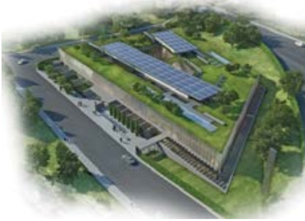
Şekil 1: Şişecam ARGE binası (URL-1)
