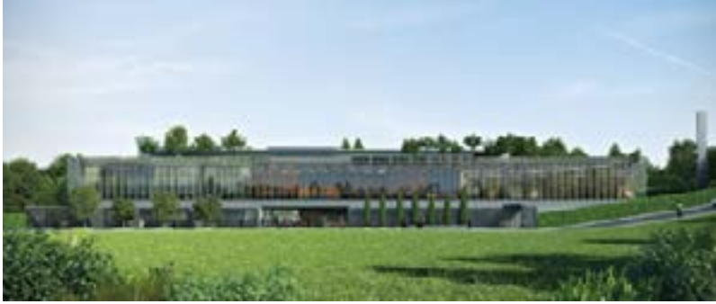
Şekil 6:Şişecam ARGE binası (URL-6)
