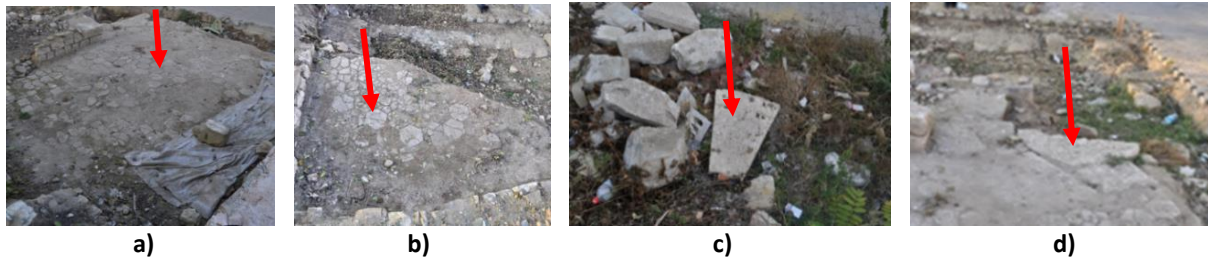
Şekil 9. a) Harim bölümündeki orijinal altıgen döşeme taşları b) Son cemaat bölümündeki orijinal altıgen döşeme taşları c) Minare şerefe döşeme taşı d) Pencere ayna taşı (Zağra, 2022)
