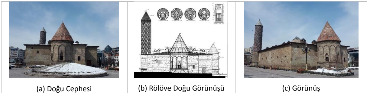
Şekil 5. “Yakutiye Medresesi”, doğu / arka cephesi (a, c: Temur, 2022, b: A Proje, 2005)
