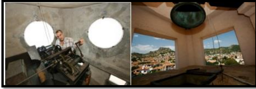
Şekil 15. (sol) Saat kulesine mekanik oda, (sağ) son katman Çan Kulesi****
