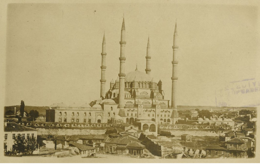
Resim 3: Selimiye Camii'nin batısındaki dükkân kalıntıları 56
