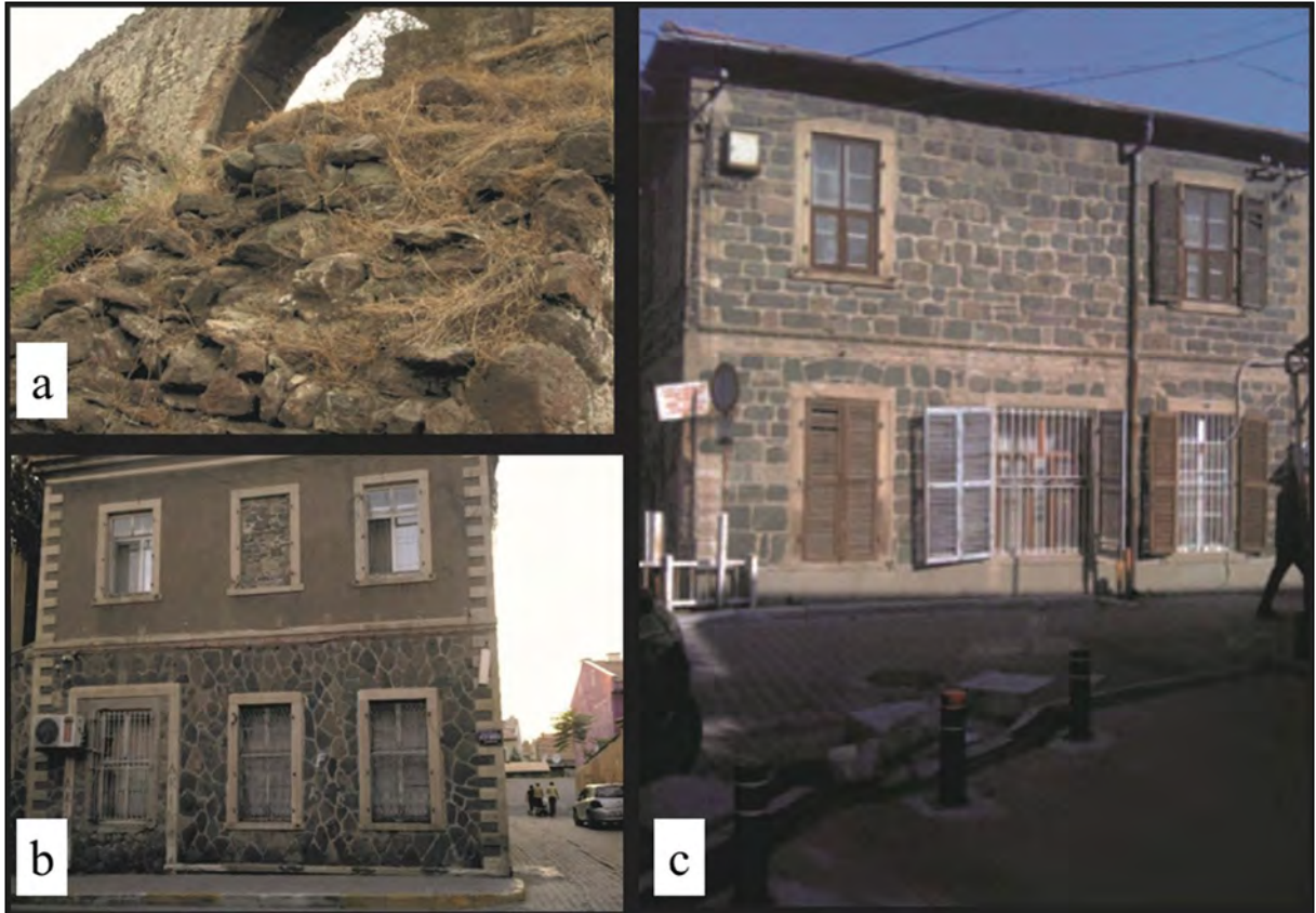
Şekil 1- a) Antik Roma Dönemi’nden kalma su kemerinde kullanılan yeşil andezitler (Yer Buca Mevkii), b) Dış cephe kaplamasında yeşil andezit kullanılmış bir Levanten evi (Buca-Uğur Mumcu Caddesi) ve c) Dış cephesinde yeşil andezit kullanılmış tarihi bina (Alsancak Garı yanı).
