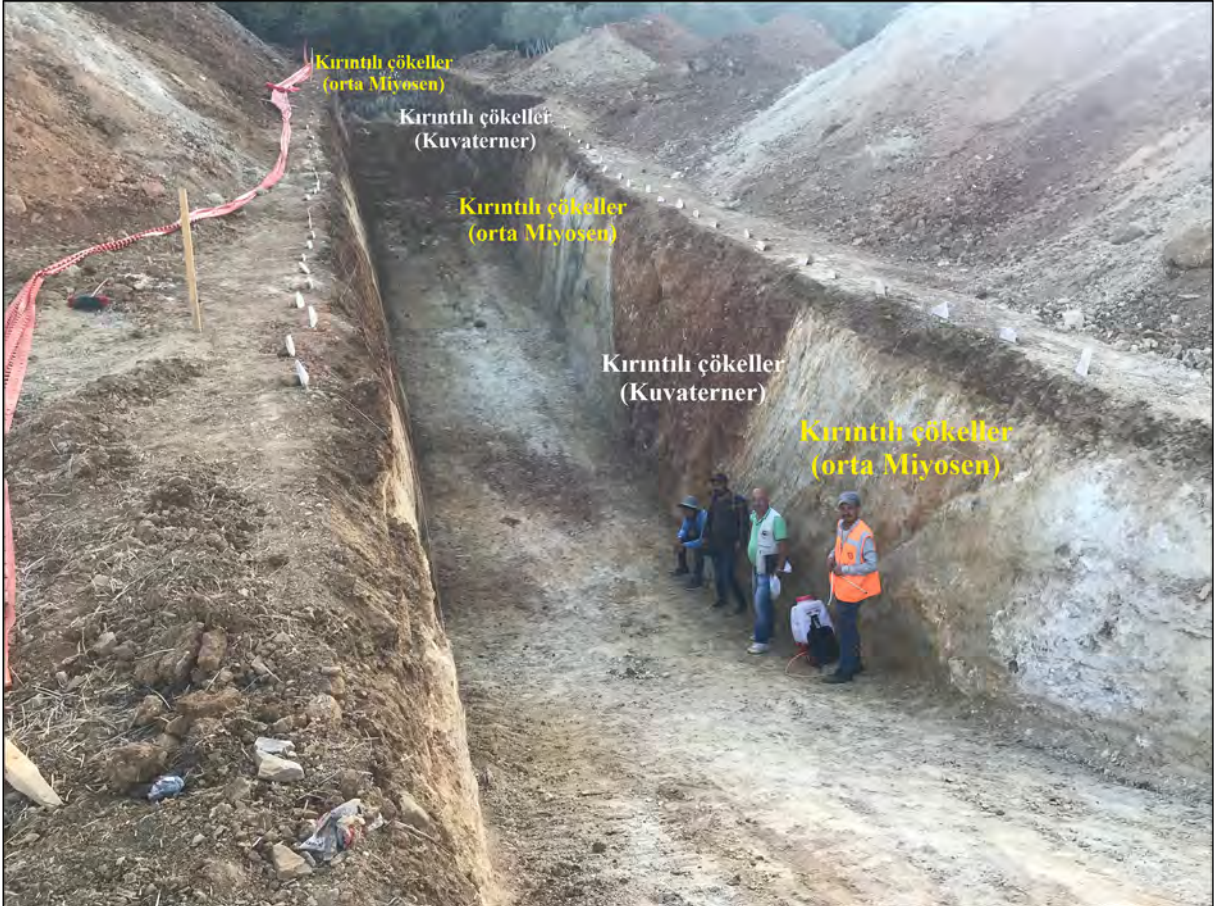
Şekil 11- Paşapınarı Hendeği genel görünümü (Bakış Güney'e).
