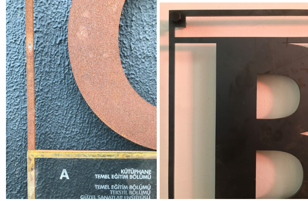
Resim 10. Kullanılan saç malzemenin zamanla paslanması öngörülmüş-tür. (Görsel kaynak: Yazarın kendi çektiği fotoğraf.)
