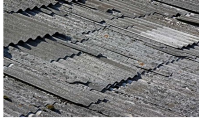
Şekil 2: Asbestli levha ile kaplı bir çatı [14]
