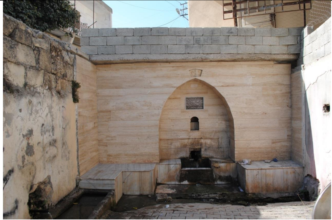
Fot.14: Yoncakaya Mahalle Çeşmesi 2 – Kuzey Cephesi
