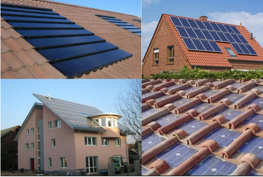
Şekil 6. Sol üstte geniş FV modülü, sağ üstte eğimli çatı kiremiti (BIPV), sol altta BIPV uygulama, sağ altta çatı üstü BAPV uygulama (URL-11, URL-12, URL-13, URL-14).
