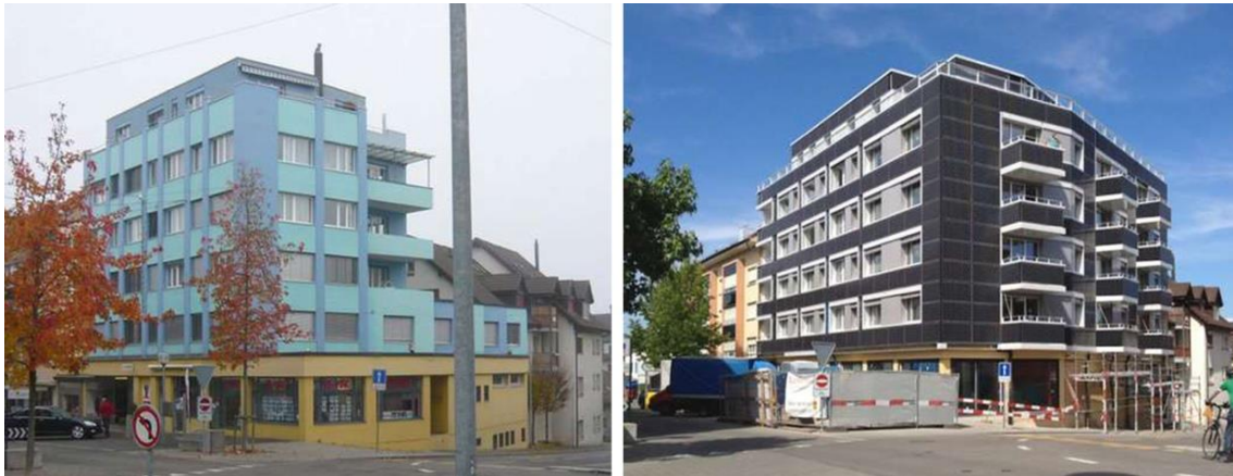
Şekil 8. Binaya sonradan entegre edilen FV sistem (BAPV), MFH Alleestrasse binası, İsviçre (URL-6)
