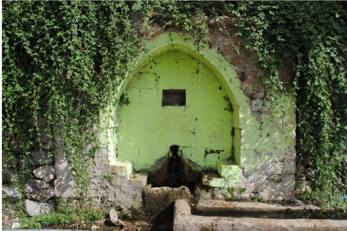
Fot. 18: Dağdüzü Mahalle Çeşmesi 2 – Batı Cephesi
