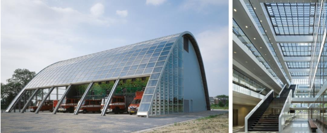
Şekil 7. Houten İtfaiye Binası (solda), FV atrium uygulaması, Nijmegen Radboud Üniversitesi, Hollanda (URL-15, URL 16)
