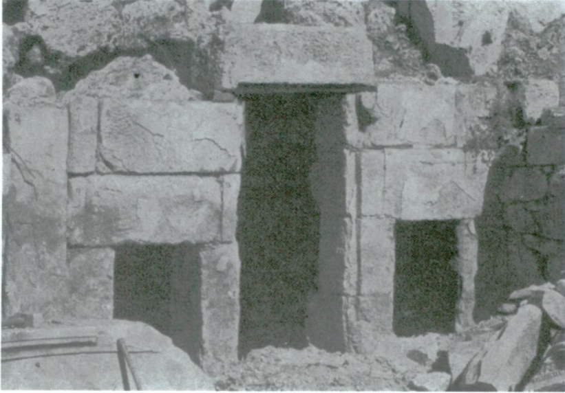
Res. 42 — Şapelin önündeki kapılı ve pencereli duvar
