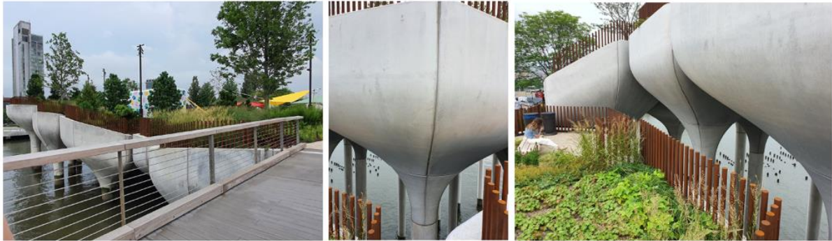
Şekil 10. Kazıkların Üzerinde Kurgulanmış Beton Strüktür (Yazar Arşivi, 2021)
