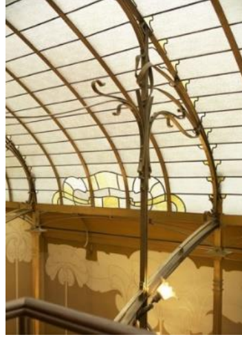
Şekil. 2 Demir Taşıyıcı Detayı. (Comberg, 2018)
