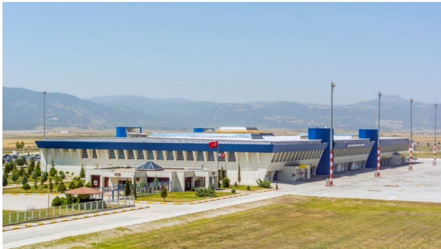
Foto 2: Denizli Çardak Havalimanı
