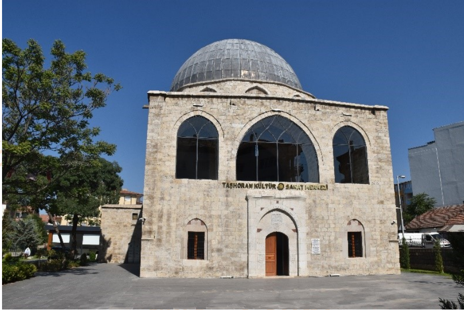
Görsel 2: Taşhoron Kilisesi Ön Cephe
