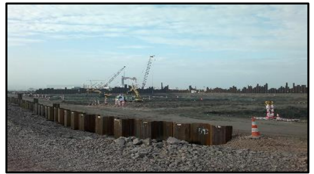
Şekil 4. Kuru havuz palplanş çakımı ile ilgili saha fotoğrafları
