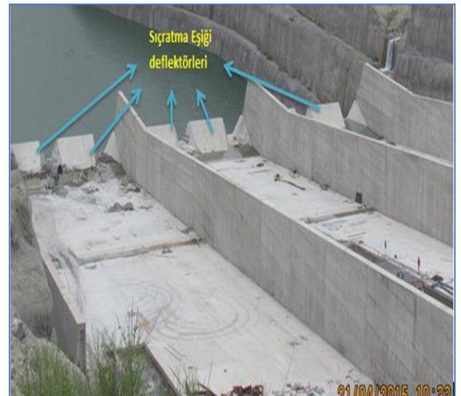
Şekil 5. Dişli Sıçratma Eşiği (Slotted Bucket)
