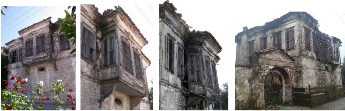
Fot.1-4: Bekir Ağa Konağı'nın restorasyon öncesi görünüşleri (Fot.1-2: A. Diler'den, Fot.3-4: F. Aykut'tan)
