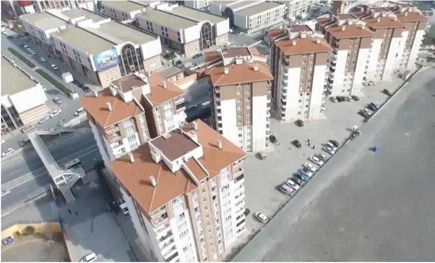
Şekil 5. Turgut Reis mahallesi'nde tamamlanan bir kentsel dönüşüm alanlarından bir tanesi (Kiptaş Konutları) (Anonim, 2022j).
