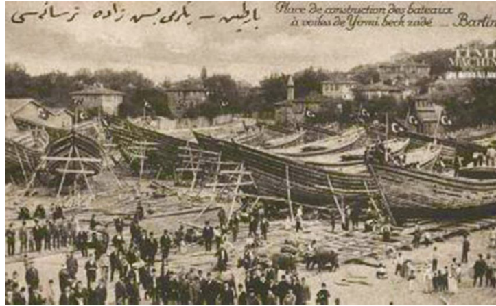
Şekil 25. Bartın'da gemi inşaatçılığı
