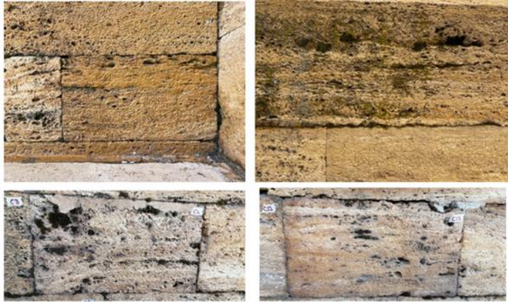
Resim 9. Taş Yüzeylerdeki Mikrobiyolojik Oluşumlar (Fotoğraf:Y. Sayın)
