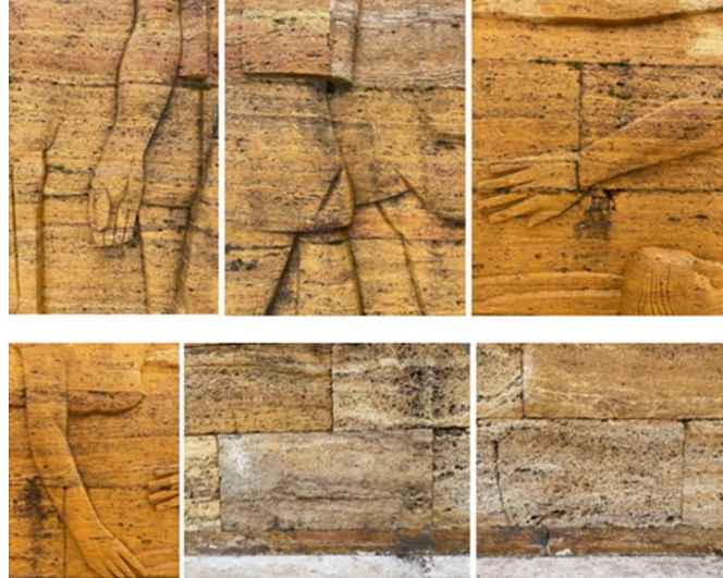
Resim 6. Taş Yüzeylerdeki Siyah Kabuk Oluşumları (Fotoğraf: M.Cura)
