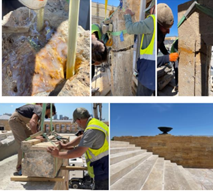
Resim 14. Taşların Yapıştırılması ve Yerine Yerleştirilmesi (Fotoğraf: O. Sakarya)
