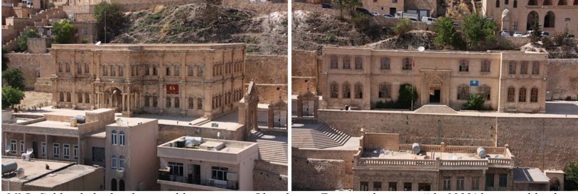
Şekil 8. Solda idadi olarak inşa edilen günümüz Olgunlaşma Enstitüsü binası, sağda 1932'de inşa edilen bugün Gazipaşa İlköğretim Okulu olarak kullanılan ek bina (Murat Çağlayan Arşivi)
