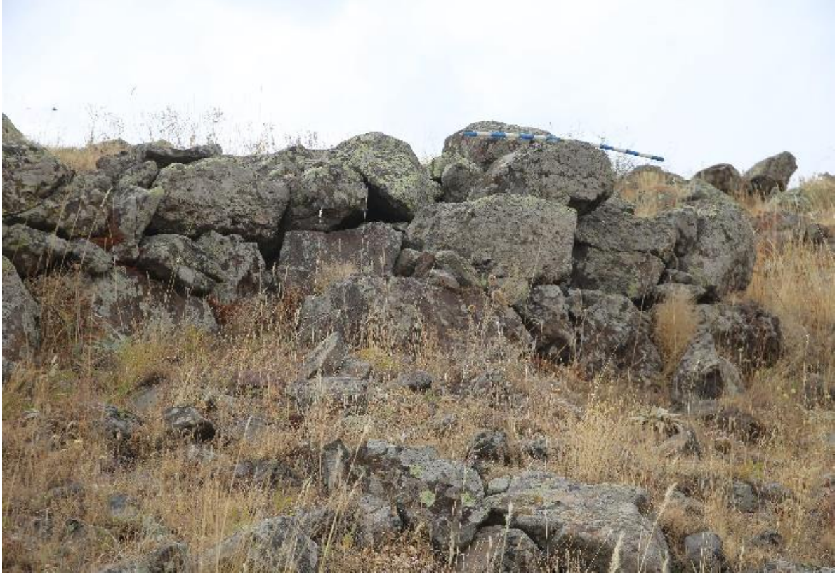
Görsel 2. Turaç I Kalesi Kikolopik Sur Duvarları
