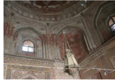
Şekil 59. Cami Detayı (URL 14) (Figure 59. Details of the Mosque)
