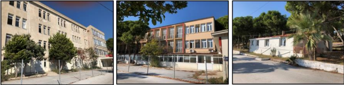
Şekil 26 - Karantina Adası'nda yer alan 19. yüzyıl sonrası inşa edilen yapılar (2019).
