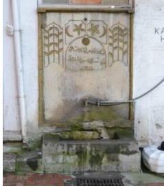
Şekil 44. Cami Arkası Sokak Çeşmesi
