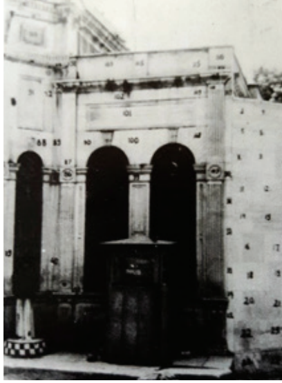
G. 27: Perteviyal Valide Sultan Türbesi Sökülmeden Önce (İşli, İstanbul'un Ortası Aksaray , 98)
