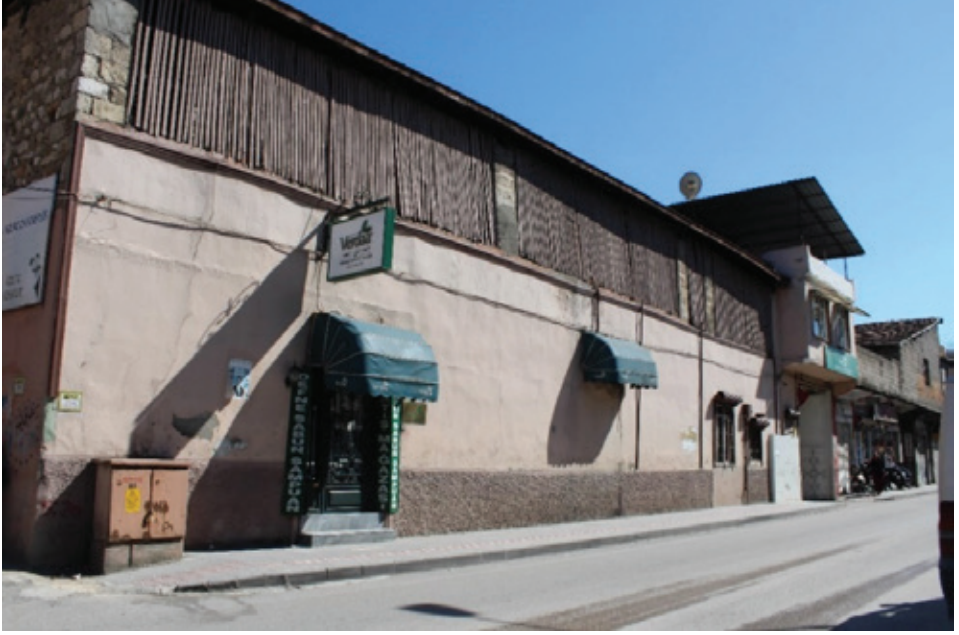
G. 19: Selahattin Ökten Sabunhanesi Batı Cephesi (Çiftyürek, 2017)
