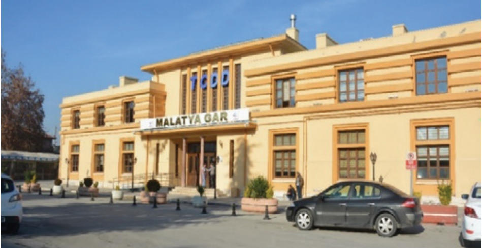
G. 11: Malatya Merkez Gar Binası Giriş (Sarı, 2019)
