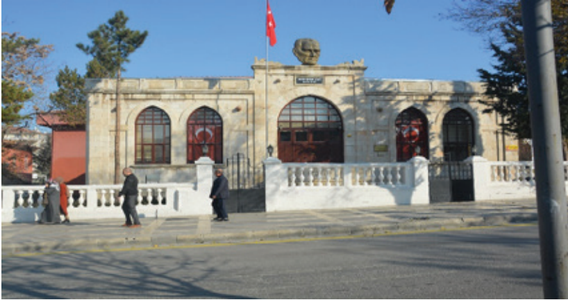
G. 7: Atatürk Evi Binası Giriş Cephesi (Sarı, 2019)
