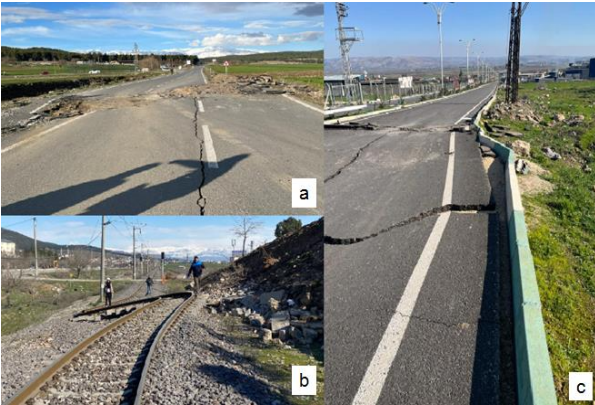
Şekil 3. Depremlerin (a,c) karayollarında ve (b) demiryollarında meydana getirmiş olduğu sol yanal deformasyon.
