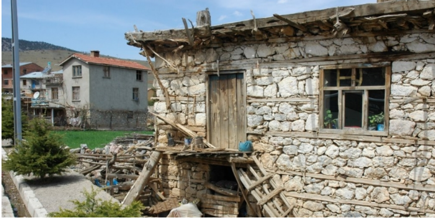
Şekil 5. Ülkemizde kargir malzeme ile yapılmış yapı örneği
