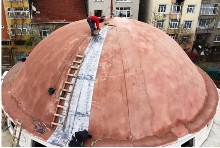
Şekil 4. Horasan harcının uygulanması
