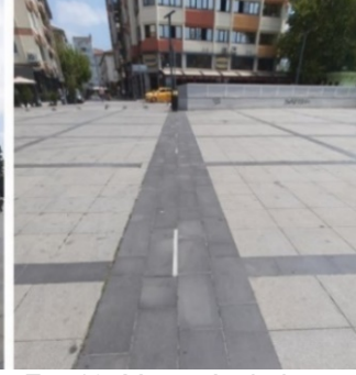
Fot.13: Yatay Aydınlatma Elemanı
