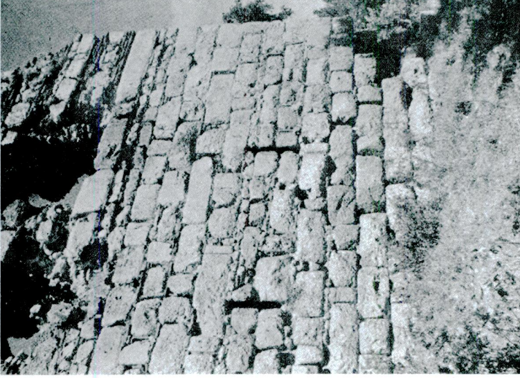
Res. 8 — Kaide kısmı ve mazgal şeklindeki menfezler.
