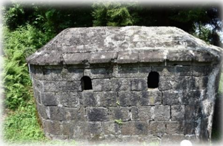
Şekil 21: Süleyman Vehbi Efendi Türbesi'nin Güney Cephesi
