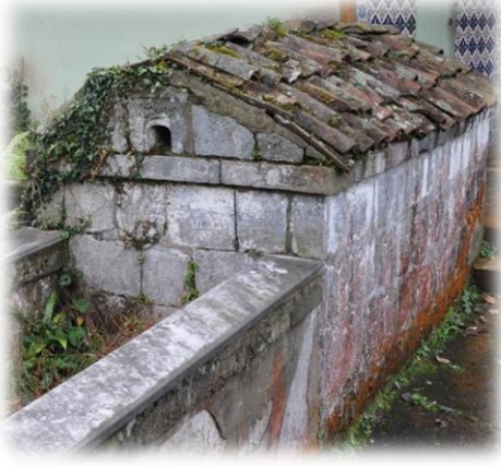
Şekil 14: Süleyman Dede Türbesi'nin Kuzeydoğu Cephesi
