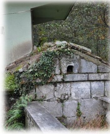
Şekil 15: Süleyman Dede Türbesi'nin Doğu Cephesi
