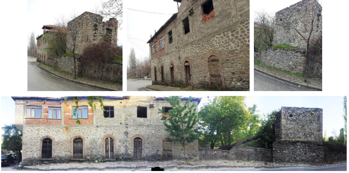
Resim 25. Kuzey Cephesi (Gökarslan ve Köse arşivi, 2022)
