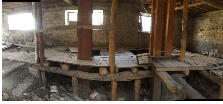
Resim 10. Hüseyin Baş Değirmeni zemin kat iç mekanı (ahşap platform, dikmeler ve çarkların konumları) (Gökarslan ve Köse arşivi, 2022)
