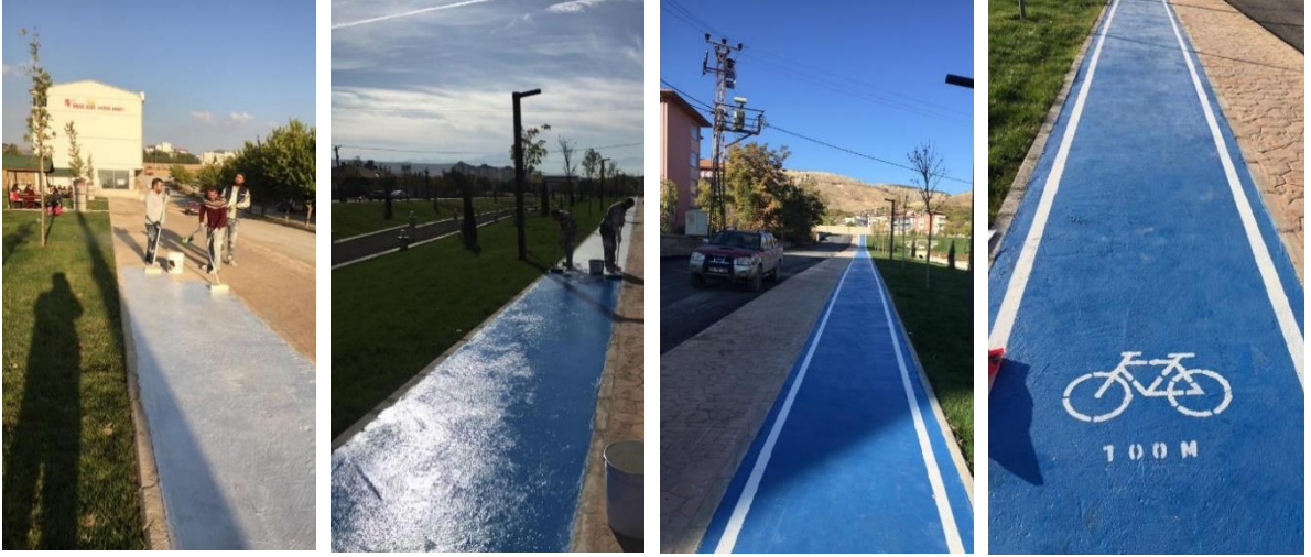
Şekil 16. Ulukent Mahallesi Bisiklet Yolu Akrilik Yapımı
