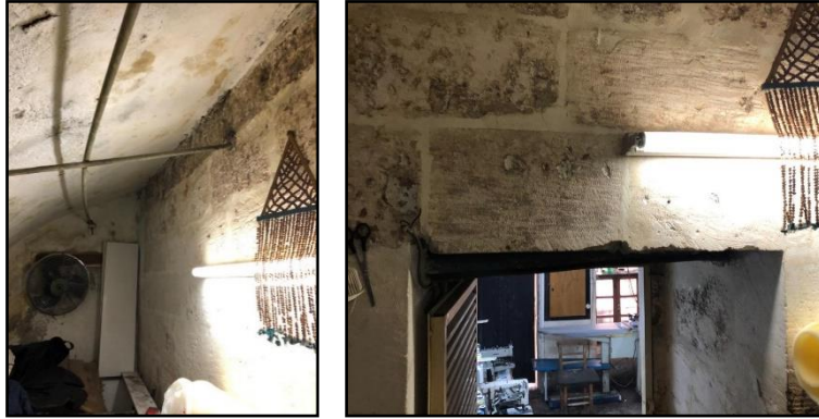
Şekil 11. Mahzen odasının duvar, sıva kaplı yarım tonoz birleşimi ile kapı geçişi (Demir, 2022)
